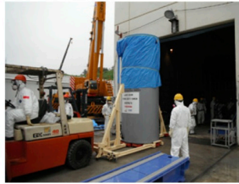
ベッセル搬入状況
