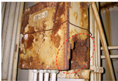
現地端子箱の腐食(穴開き)
